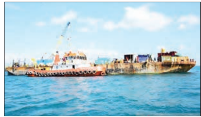
Kapal Tongkang yang memuat kabel listrik yang dibangun dibawah laut yang menghubungkan Desa Ilngata dengan Pulau Dudepo, Kecamatan Anggrek, Kabupaten Gorontalo Utara, Kamis (9/7).
