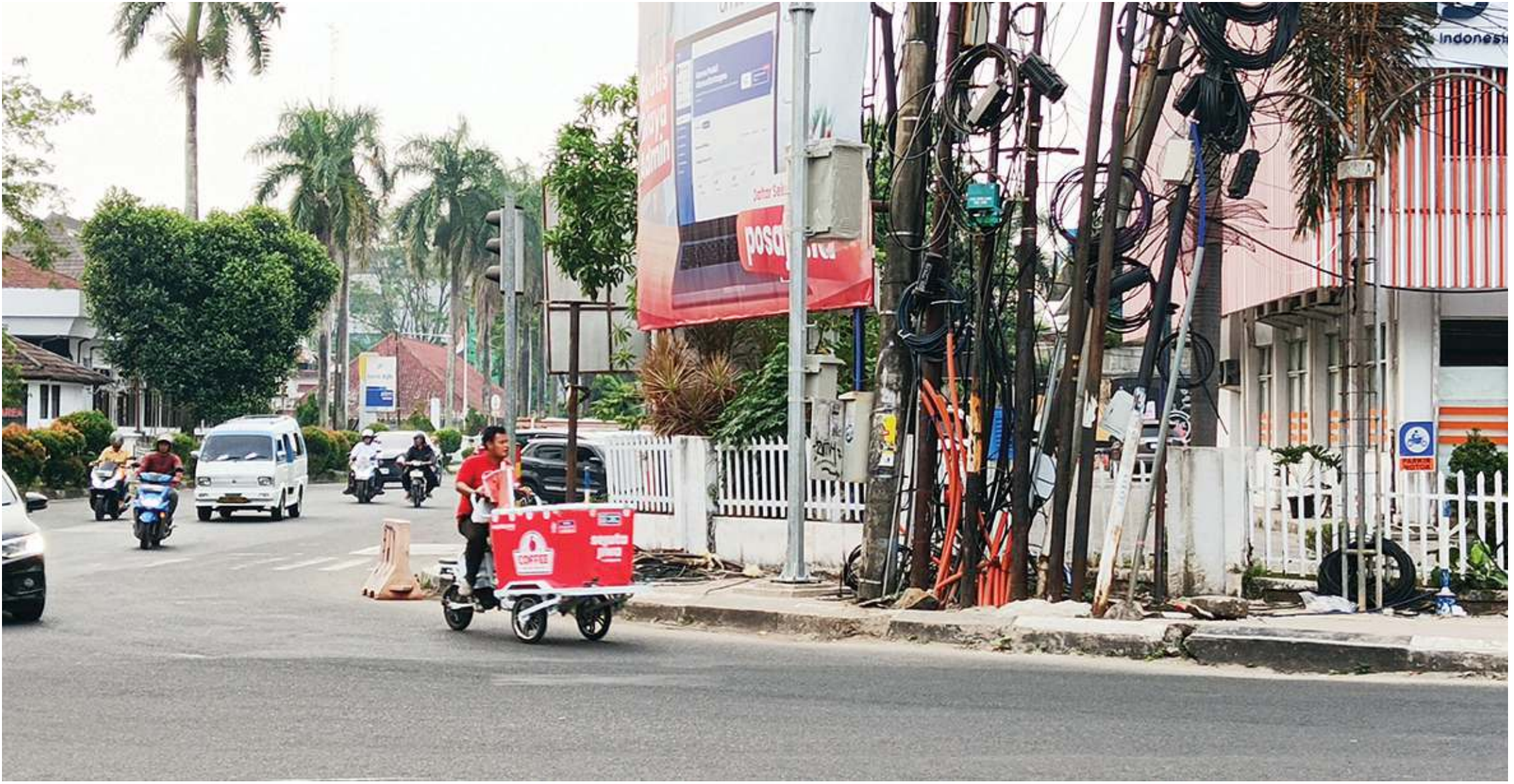
KABEL UTILITAS BERANTAKAN.
