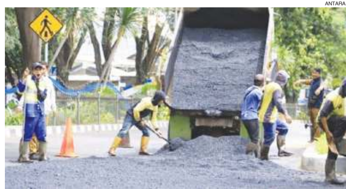
Petugas Dinas PUPR Kota Tangerang melakukan perbaikan jalan rusak.
