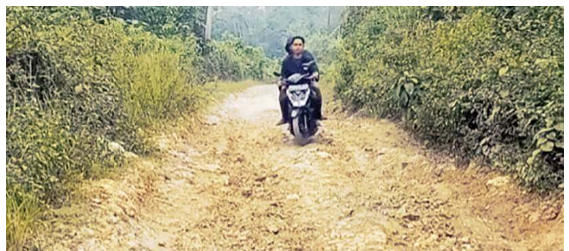
Kondisi jalan penghubung dua di Desa, Parakan Besi - Bojongmanik terlihat rusak memprihatinkan. Kondisi ini dikeluhkan warga setempat.
